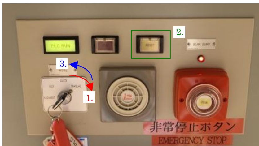
図 1 シャッター操作キー及びリセットボタン
